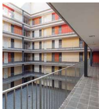
Edificio residencial de 84 apartamentos. Cornellà (Barcelona), España. Aquarea
