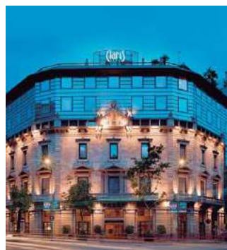
Reacondicionamiento de hotel. El sistema de recuperación de calor es ideal para un hotel de esta categoría. Hotel Claris 5 *. Barcelona, España. ECOi
