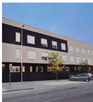
Residencia El Balcón de Valdemoro. Un edificio de 3 plantas y sótano. Valdemoro (Madrid), España. ECOi - ECO G
